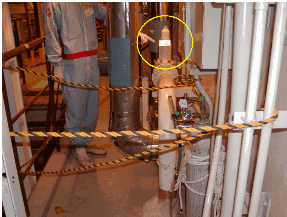
補機冷却水系統の逃がし弁
