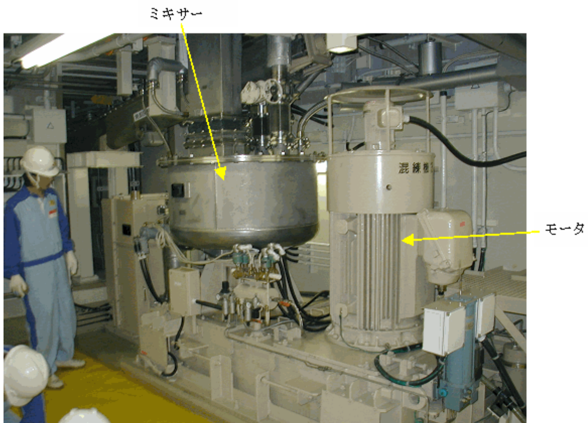
セメント固化装置混練機全景
