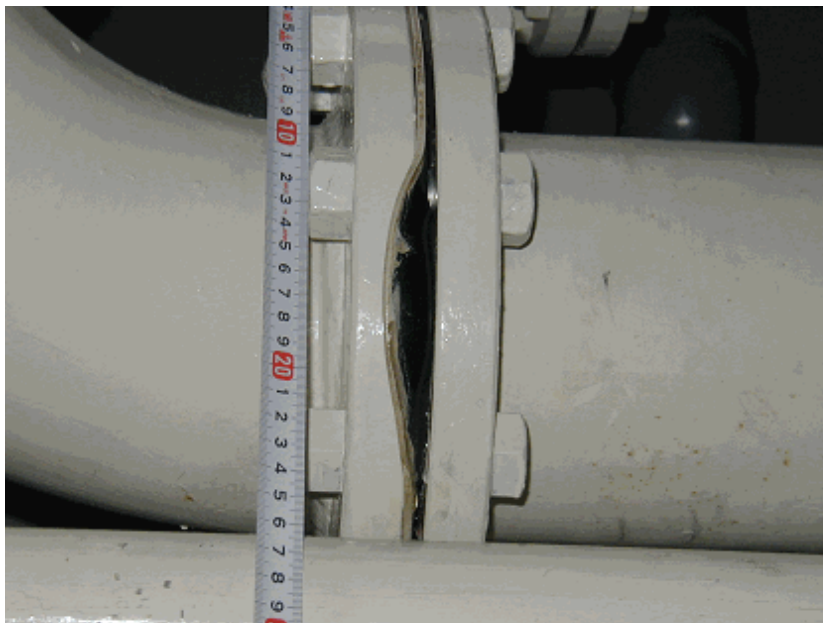
漏えいのあったフランジ部 材質：炭素鋼 管内径：約 150mm 肉厚：約 7mm
