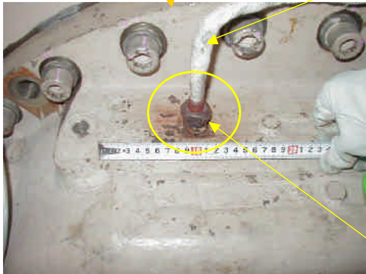
グランド蒸気圧力計検出配管継ぎ手部
