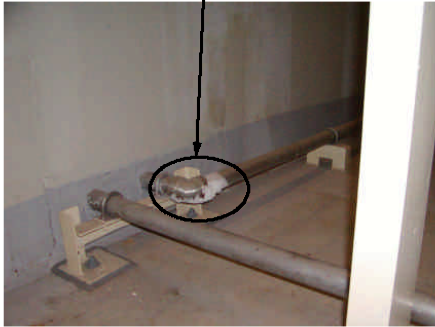
廃液貯蔵タンクドレン配管
