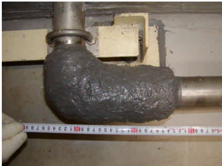
応急補修状況
