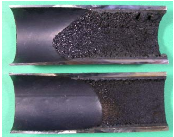
漏えい箇所近傍内面（下流側）
