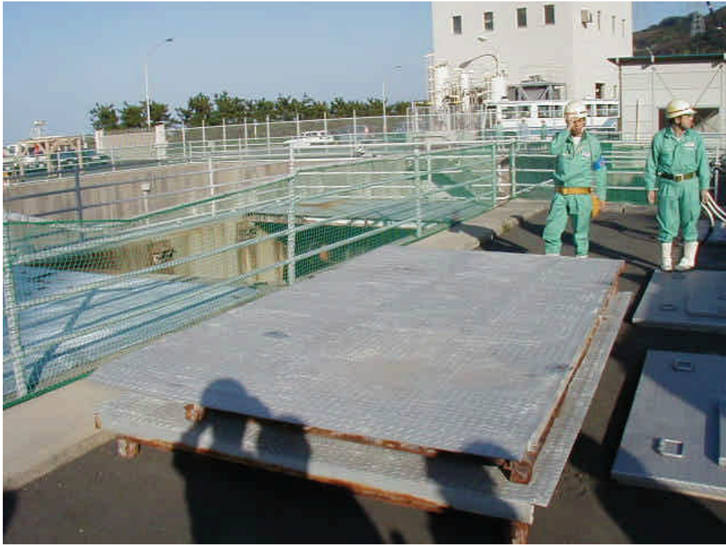
事故現場（中央は落下した鋼板）
