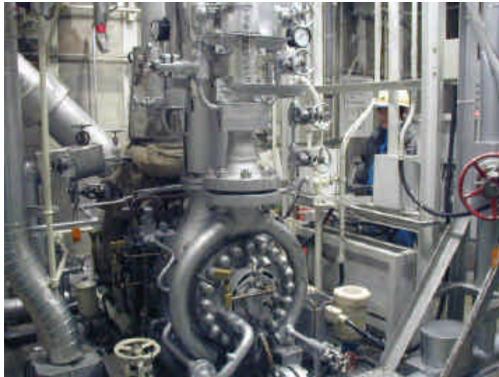
タービン動補助給水ポンプ全景
