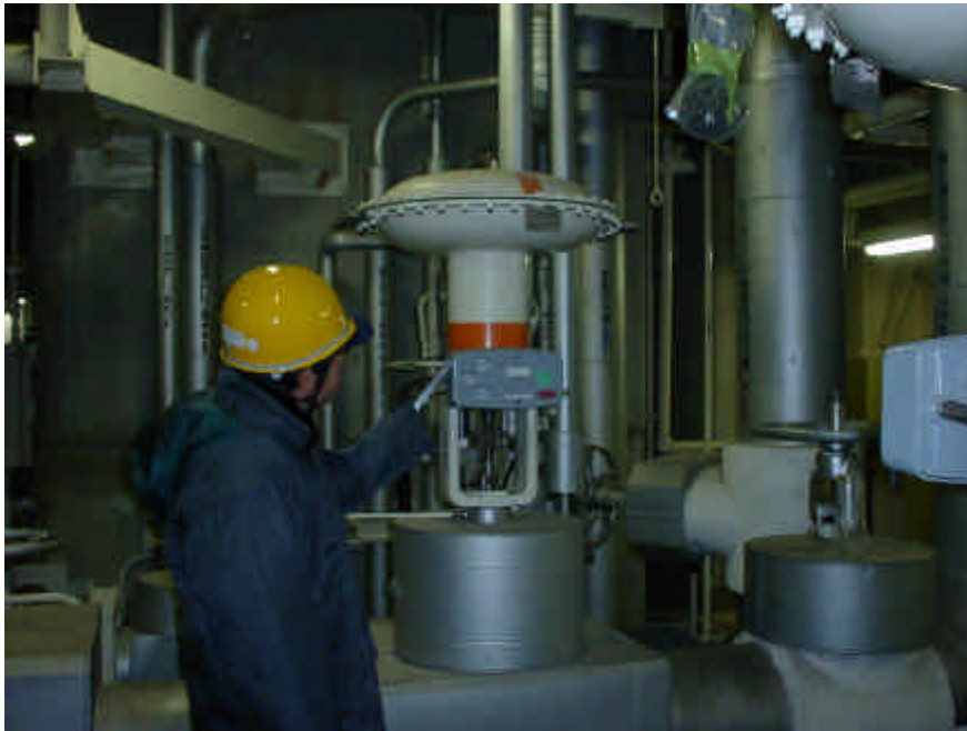
水位制御弁（空気作動弁）
