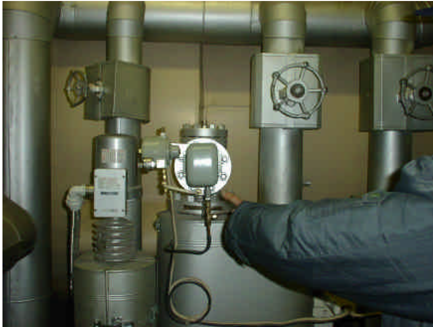
伝送器（高圧給水加熱器の水位を空気信号に変換）
