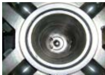
封水注入フィルタ 3 A 異常なし
