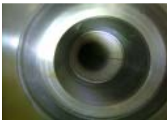
ポンプ出口配管 異常なし
