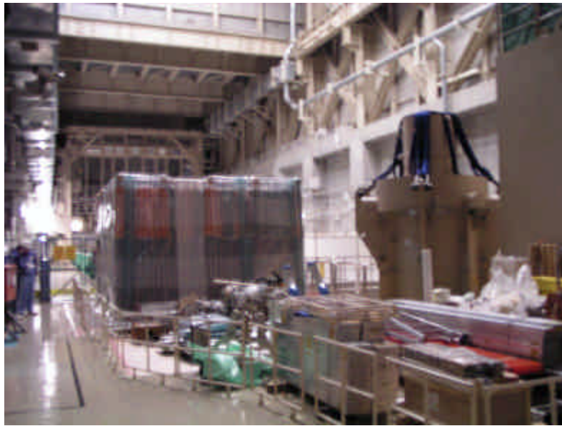
作業現場全景
