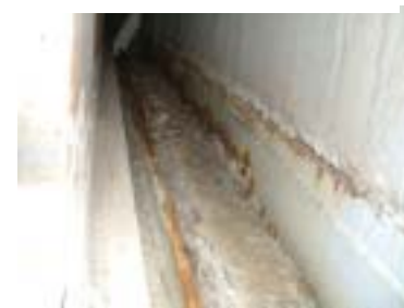
⑤排気筒水平・鉛直ダクト部の接続 鋼材部 (外周コンクリート内側)
