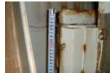
⑧排気筒水平・鉛直ダクト部の接続 鋼材部 (外周コンクリート内側)
