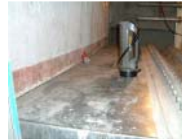
②排気筒水平ダクト部 (原子炉補助建家内)
