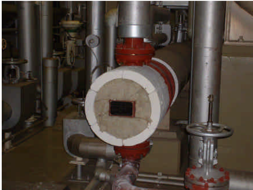
保温を取外した状態
