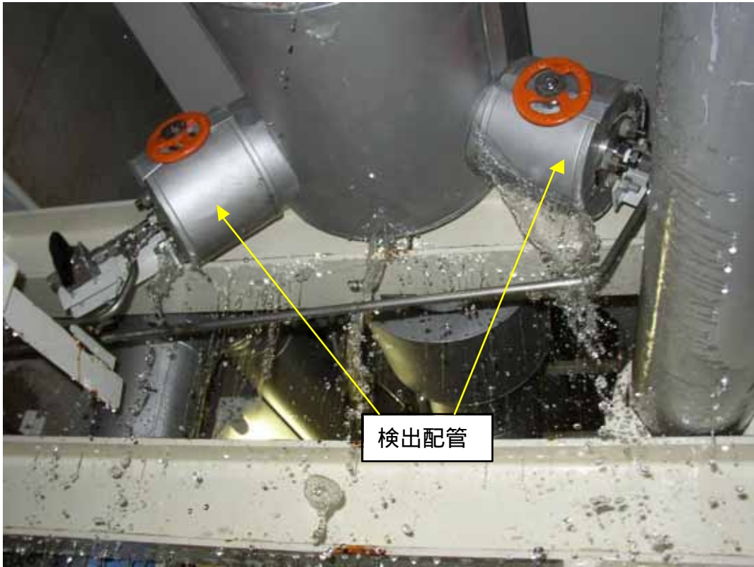
海水漏えい箇所
