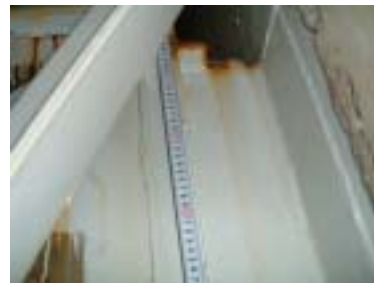
④排気筒水平・鉛直ダクト部の接続 鋼材部 (外周コンクリート内側)
