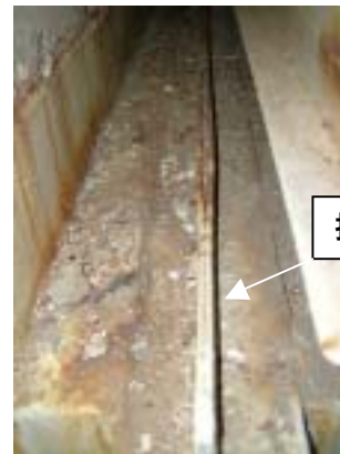
排気筒水平・鉛直ダクト部の接続鋼材部 (a 視) (外周コンクリート内側)
