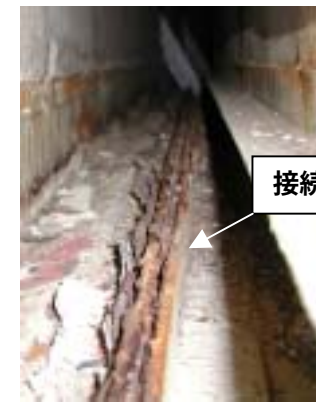
⑥排気筒水平・鉛直ダクト部の接続 鋼材部 (外周コンクリート内側)
