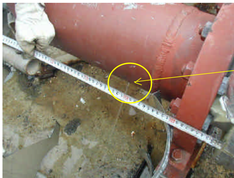
消火ポンプB 出口配管漏えい状況
