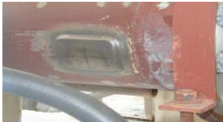
消火ポンプB 当て板溶接補修状況
