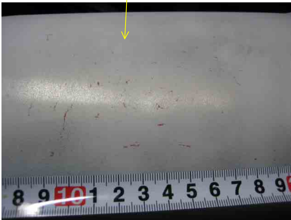
液体浸透探傷検査(PT)指示部
