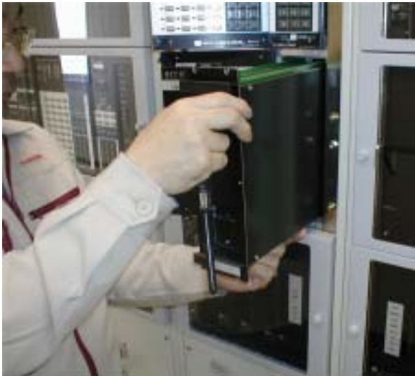
電源ユニット抜き出し
