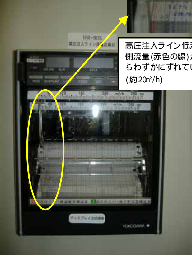
流量記録計(制御盤背面に設置)
