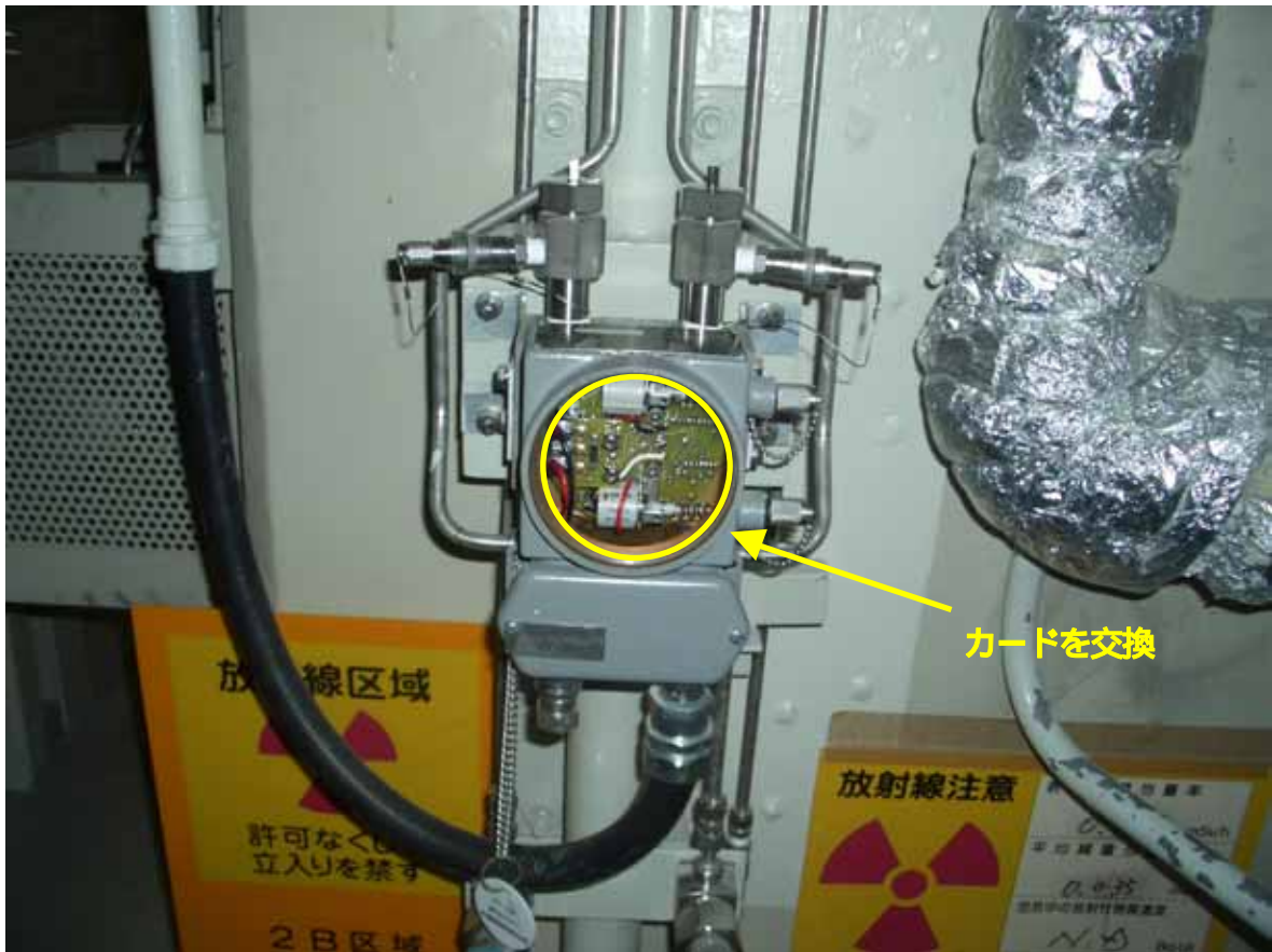
流量計故障箇所
