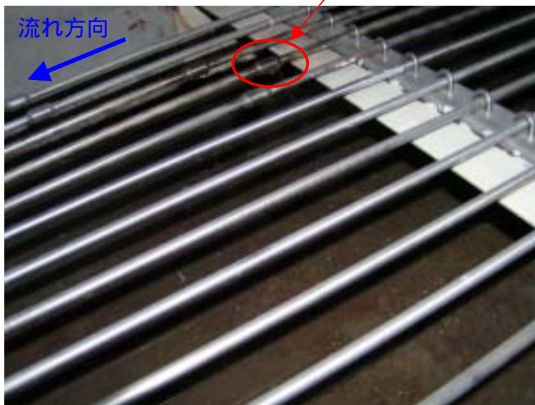
当該配管（コントロールタワー4階中間階）
