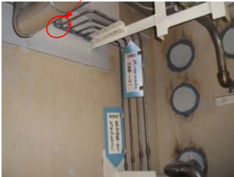
当該配管（原子炉補助建家4階 廃液フィルタ室）
