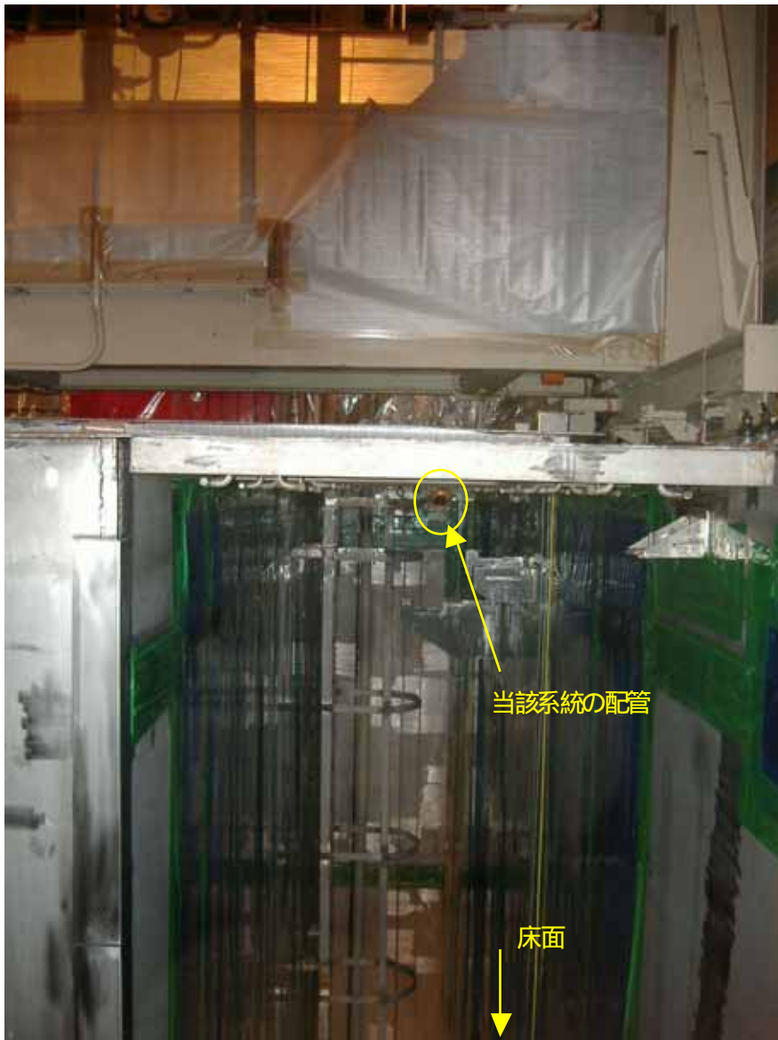
燃料移送チャンネル上部
