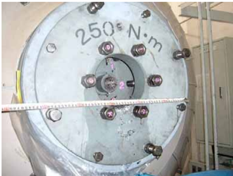
マンホールからの漏えい状況写真
