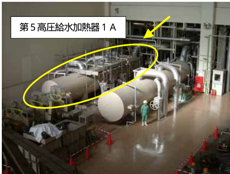
第5 高圧給水加熱器全景
