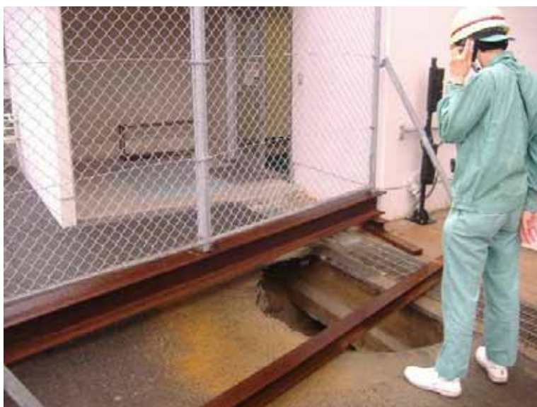
非常用排水系統配管埋設箇所陥没状況
