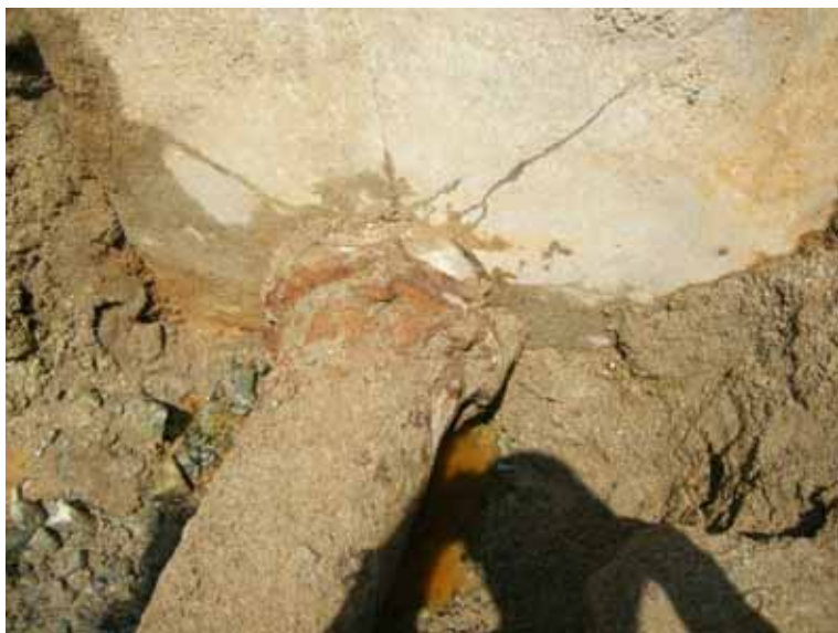
配管貫通箇所(上部から)
