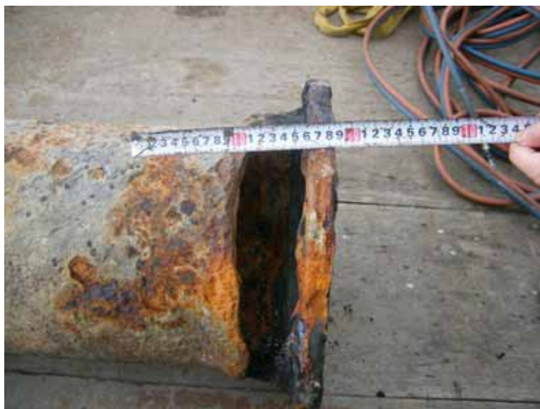
配管貫通状況(幅最大約 7 c m)
