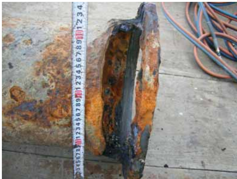
配管貫通状況(長さ約 28 c m)
