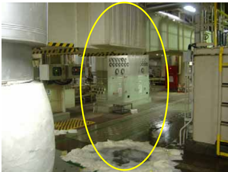
タービン建家地下1階漏水状況
