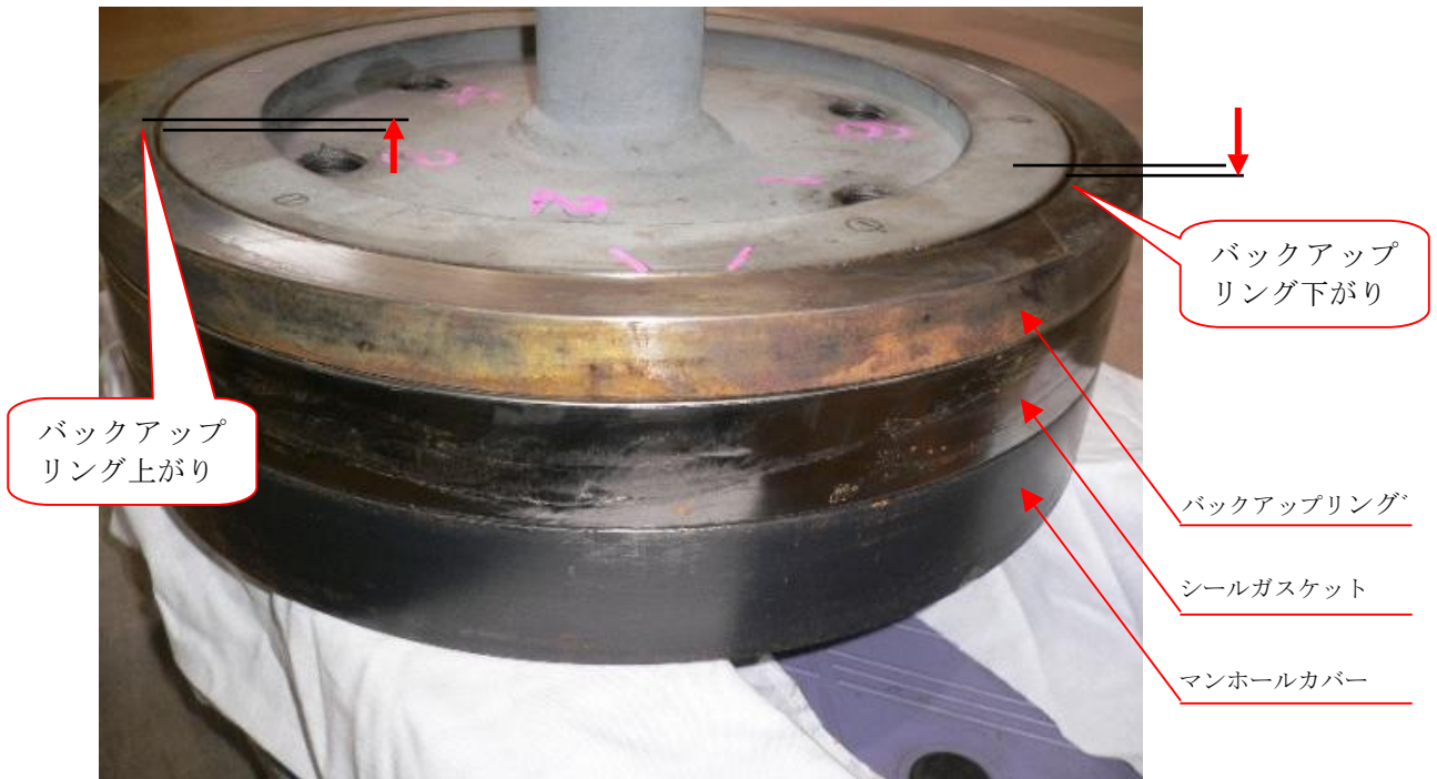
バックアップリング内径が引っかかり傾いた状態
