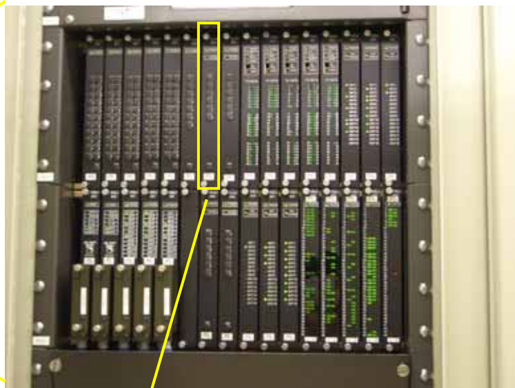
カード挿入状態確認回路部不調カード
