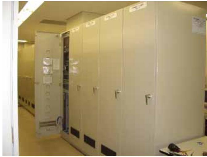
制御回路収納ユニット
