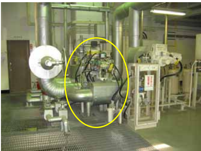
加熱蒸気制御弁
