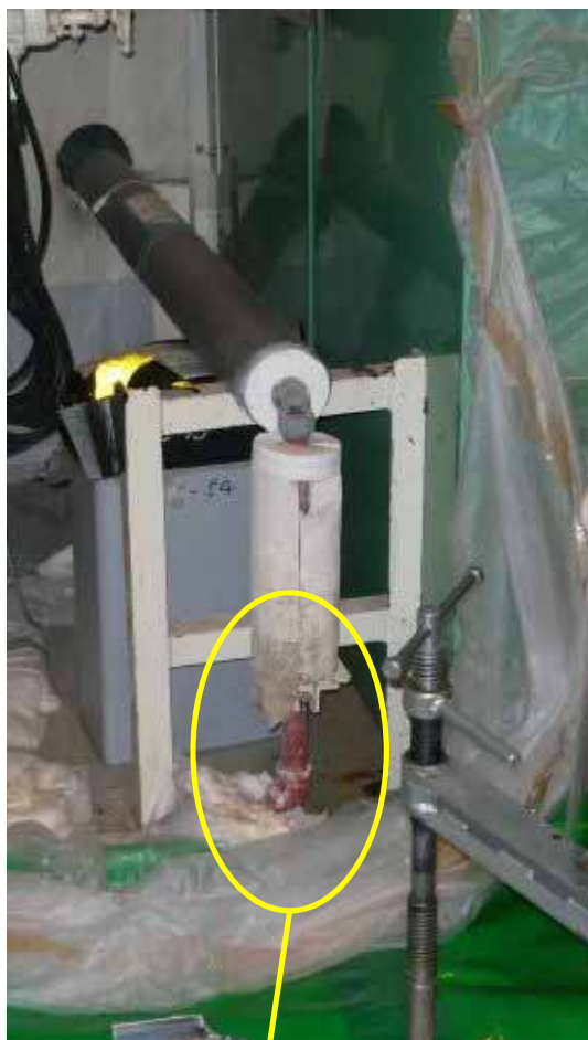
補助蒸気戻り配管
