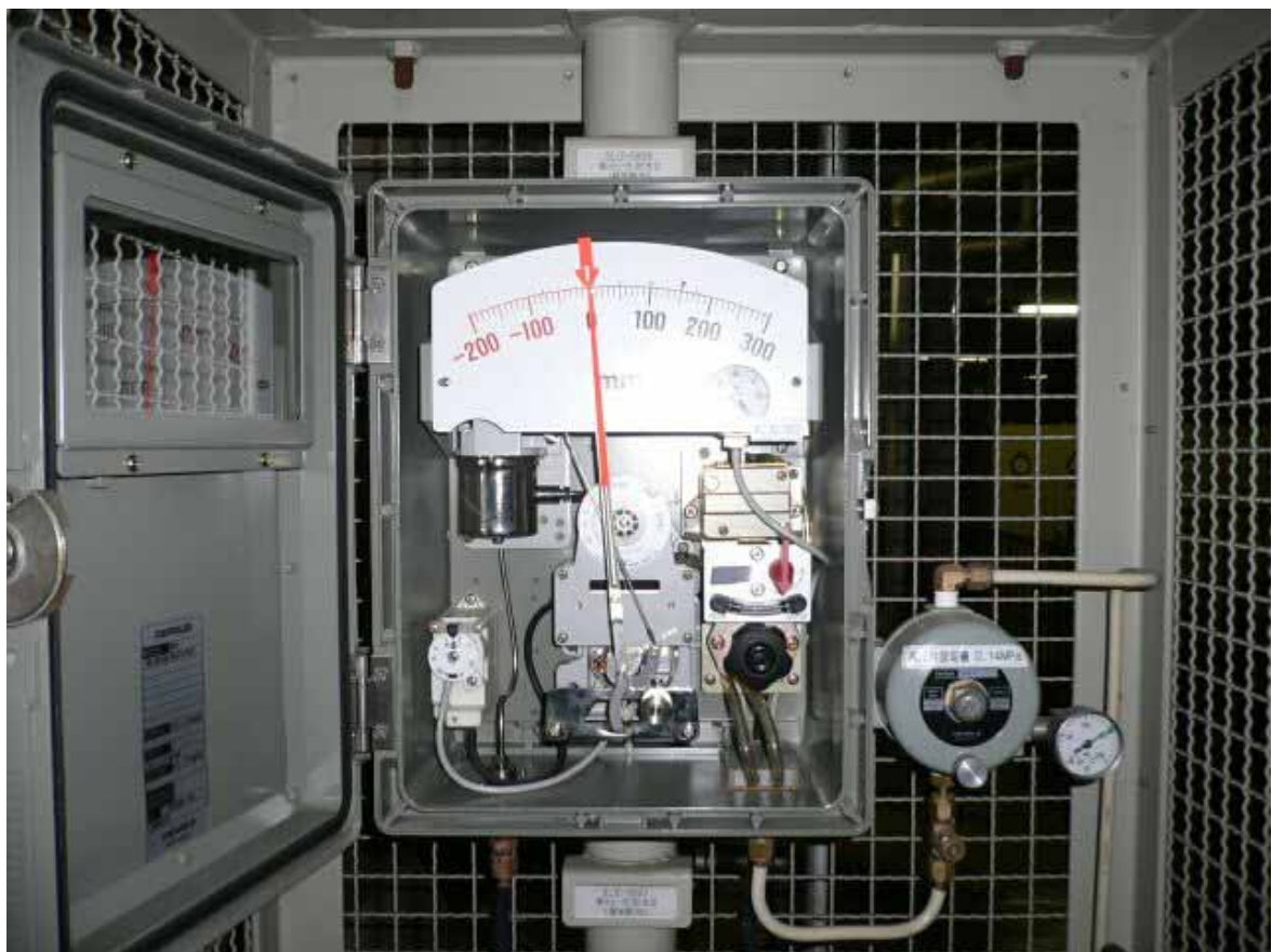
水位制御装置調節器
