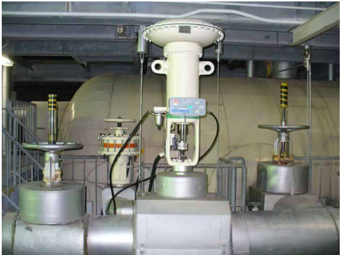
第6 高压给水加热器B 水位制御弁(常用)
