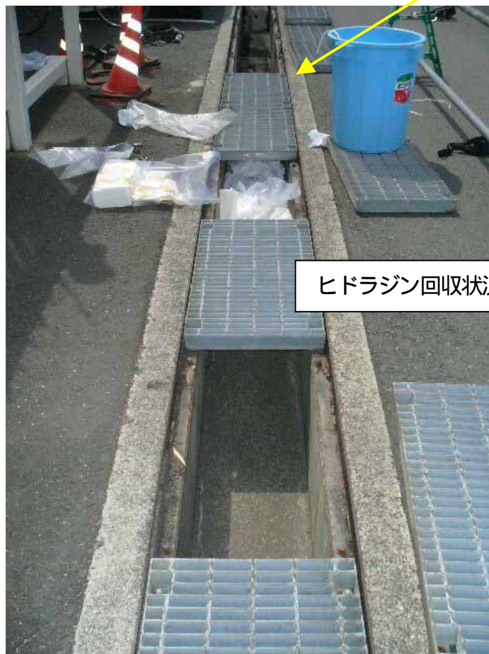
側溝のヒドラジン回収状況
