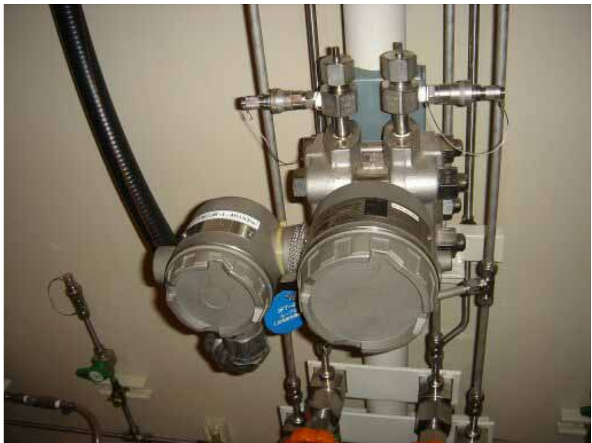
一次冷却材流量検出回路伝送器
