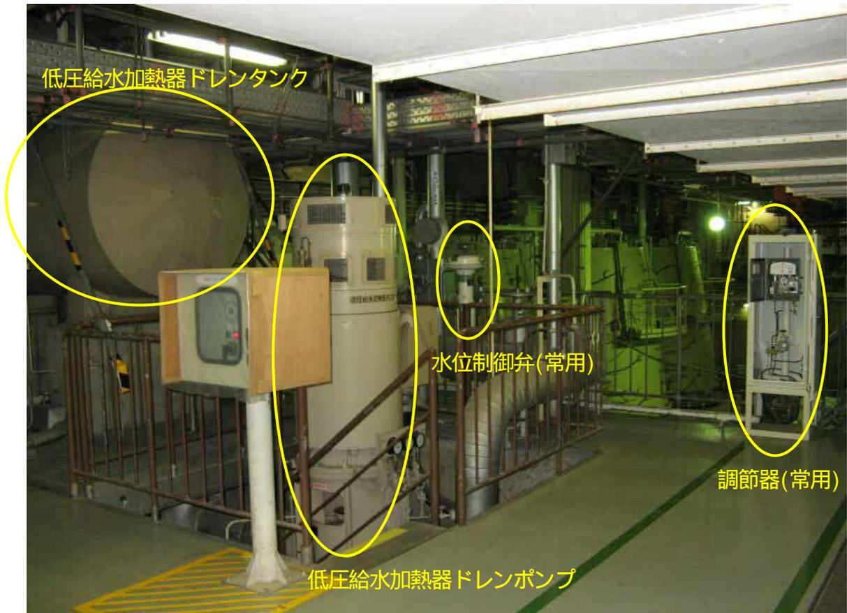
低圧給水加熱器ドレンタンク水位制御装置
