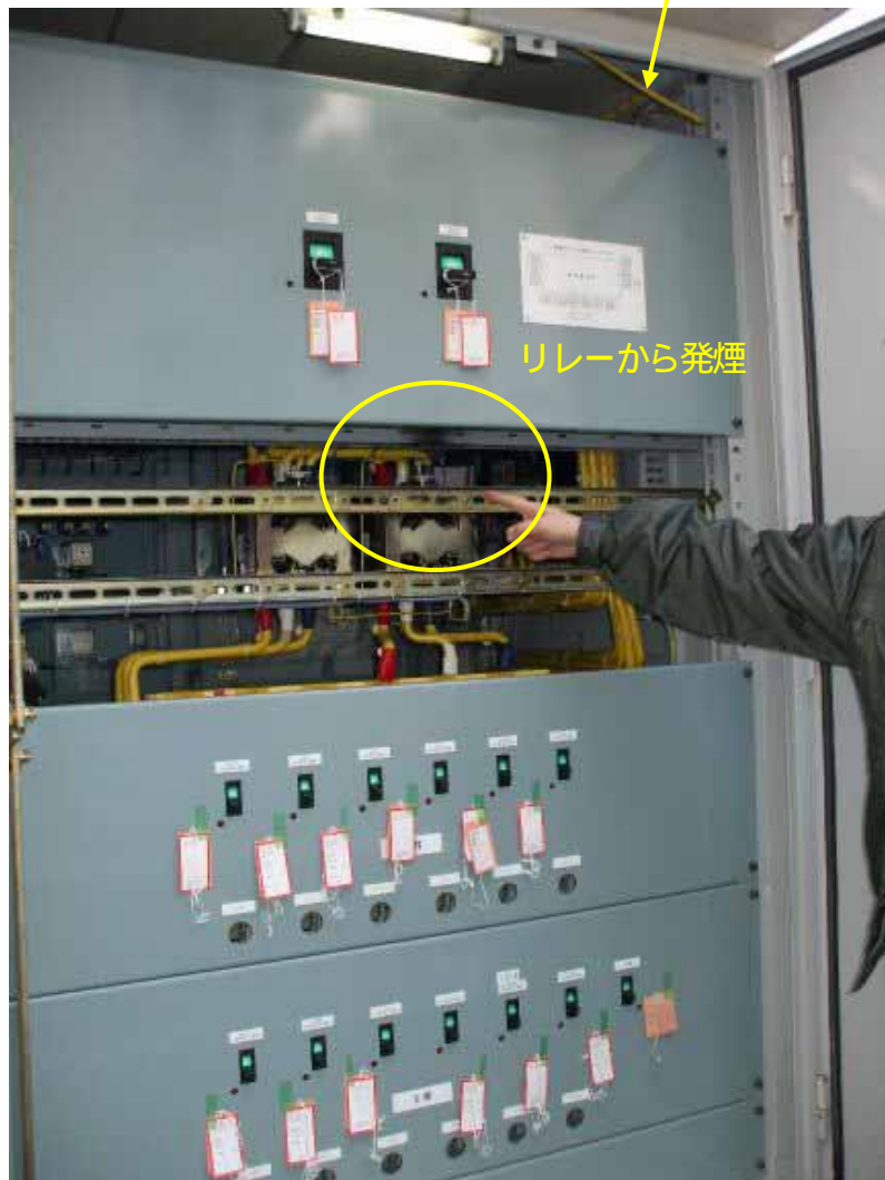
主変圧器冷却装置制御盤
