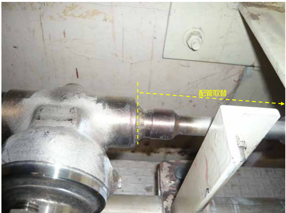
配管取替箇所
