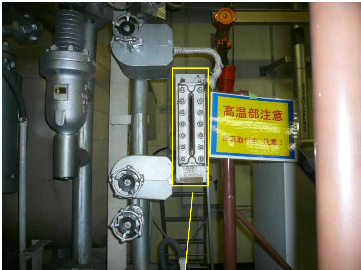
水面計復旧状況
