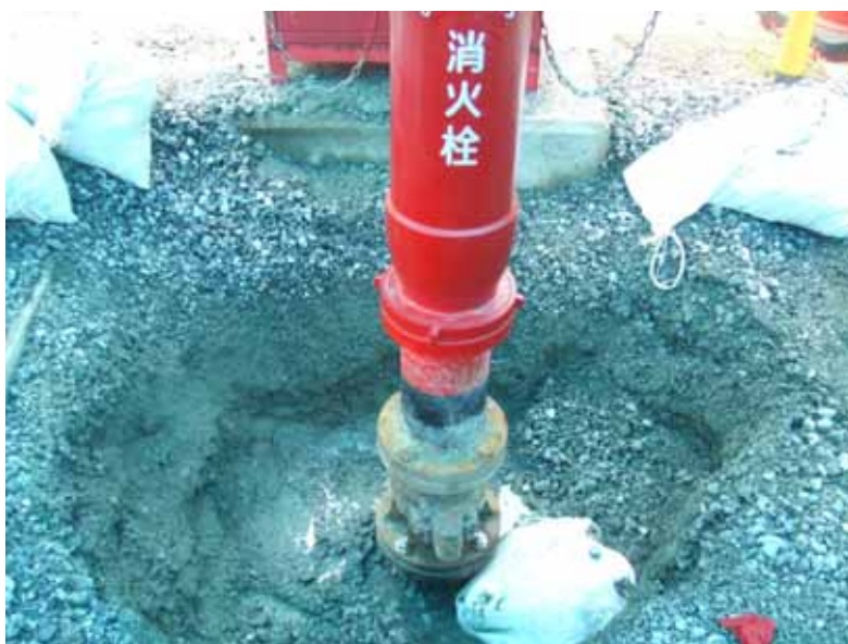
消火栓（復旧後）
