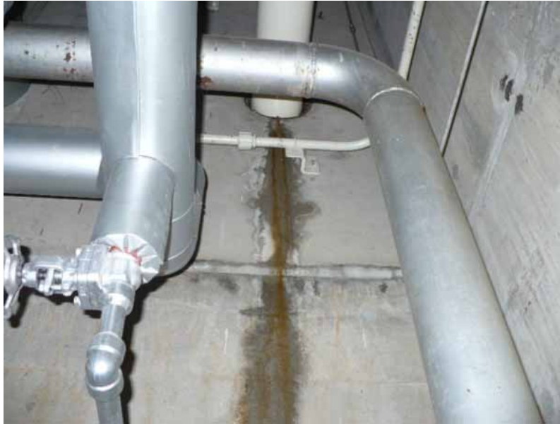
配管貫通部（下から見上げている）
