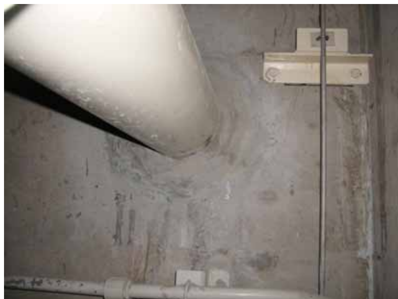
配管貫通部（コンクリート補修材等を充填し、復旧。）
