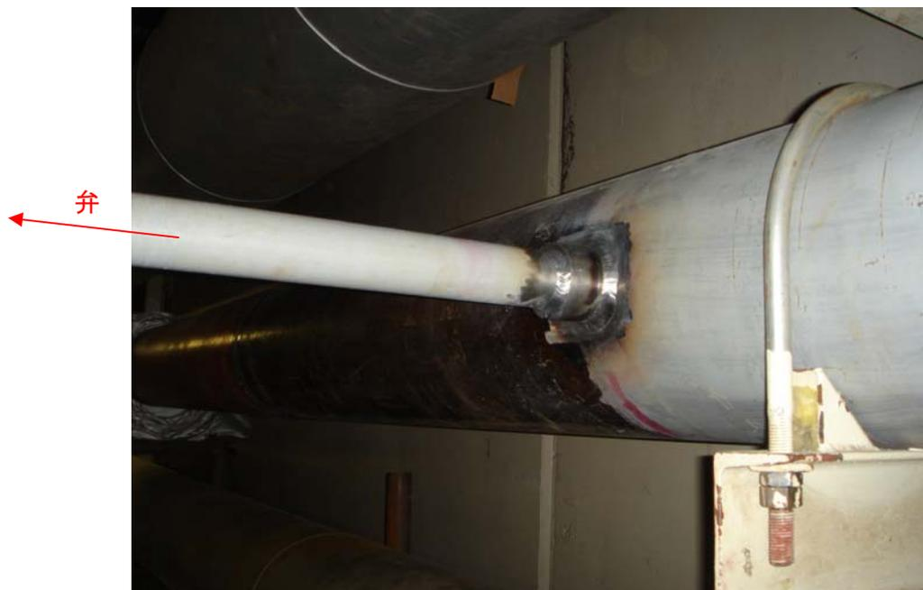
配管材質：ステンレス鋼配管
