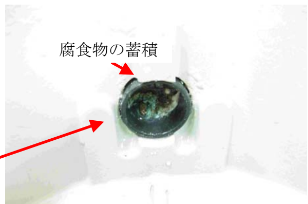
予備変圧器ダイヤル温度計 警報リード接続端子部 (上から見たところ)
