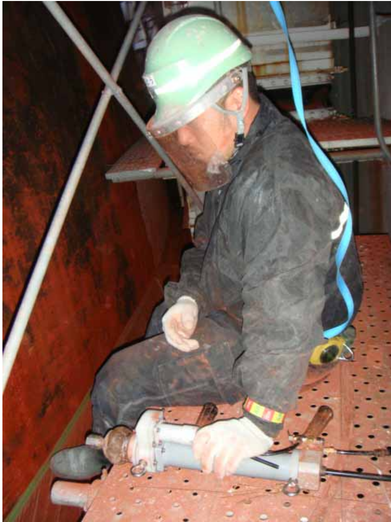
外面塗装下地処理現場の様子（再現）
