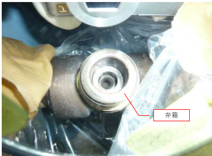
加圧器水位計の検出器元弁 分解点検状況
