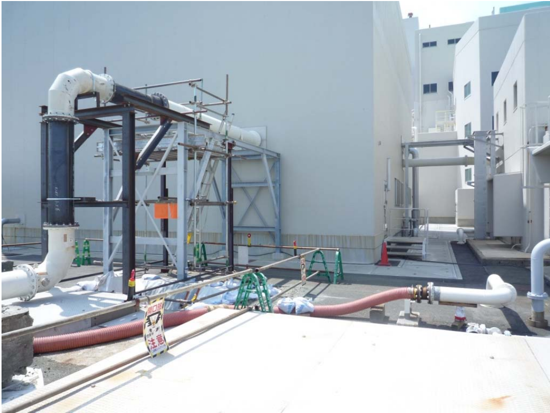
仮設配管設置状況(1,2号機海水淡水化装置建屋側)
