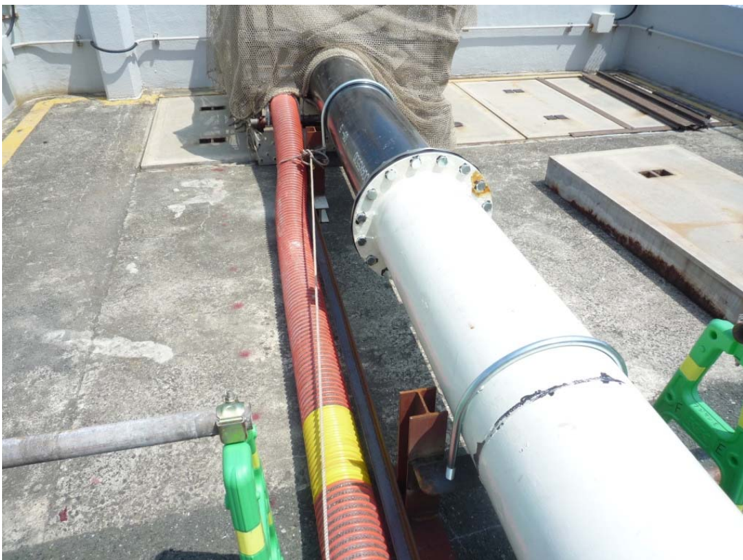
仮設配管設置状況(1,2号機海水淡水化装置放水口側)
