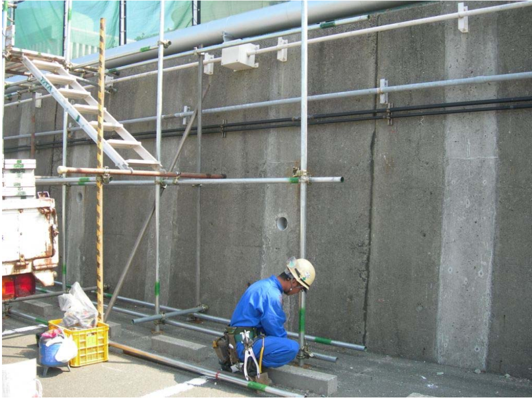
作業現場の状況
