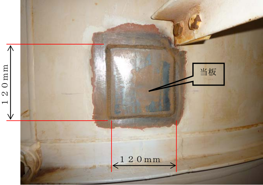
(外面当板施工状況)
