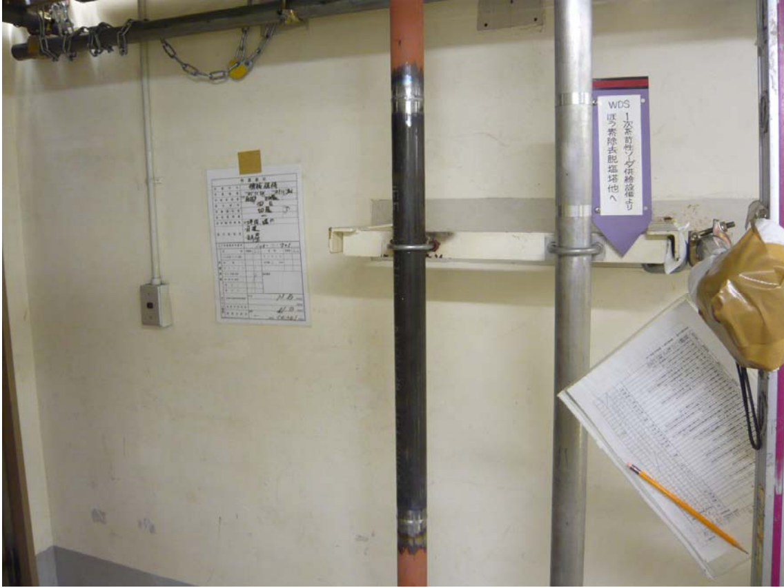
配管取替状況
