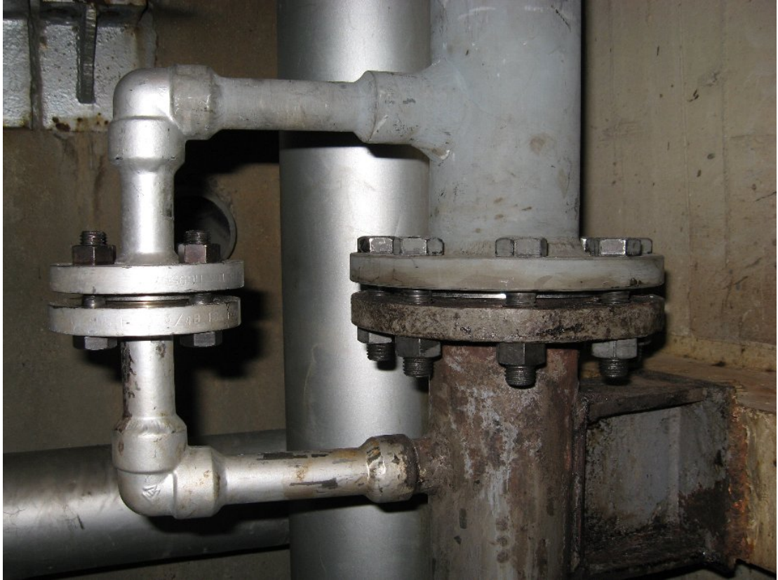
配管復旧状況
