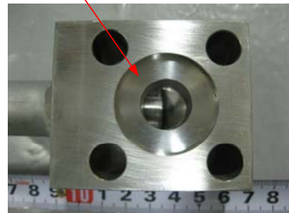
フランジ手入れ後状況 (配管側)
