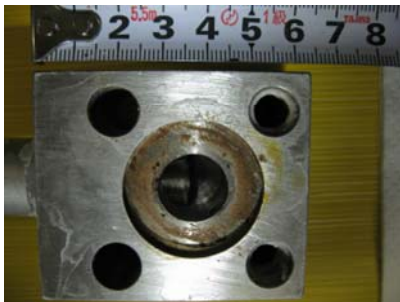
フランジ分解状況 (配管側)
