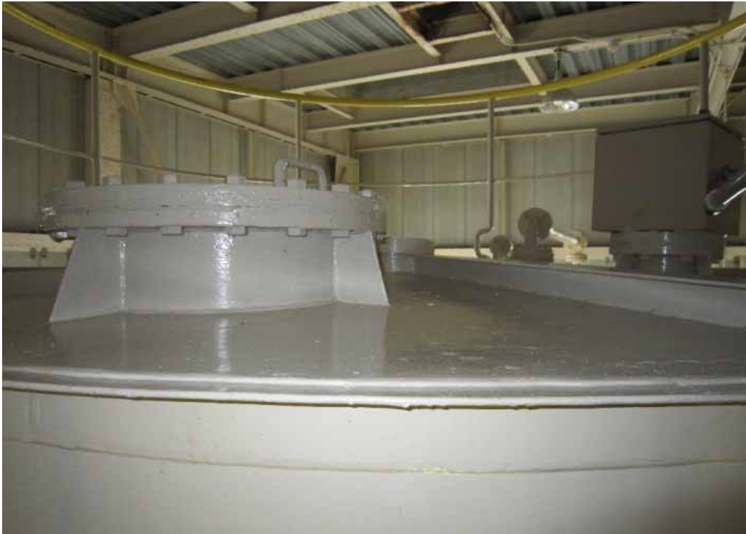
貯槽タンク上部復旧状況
