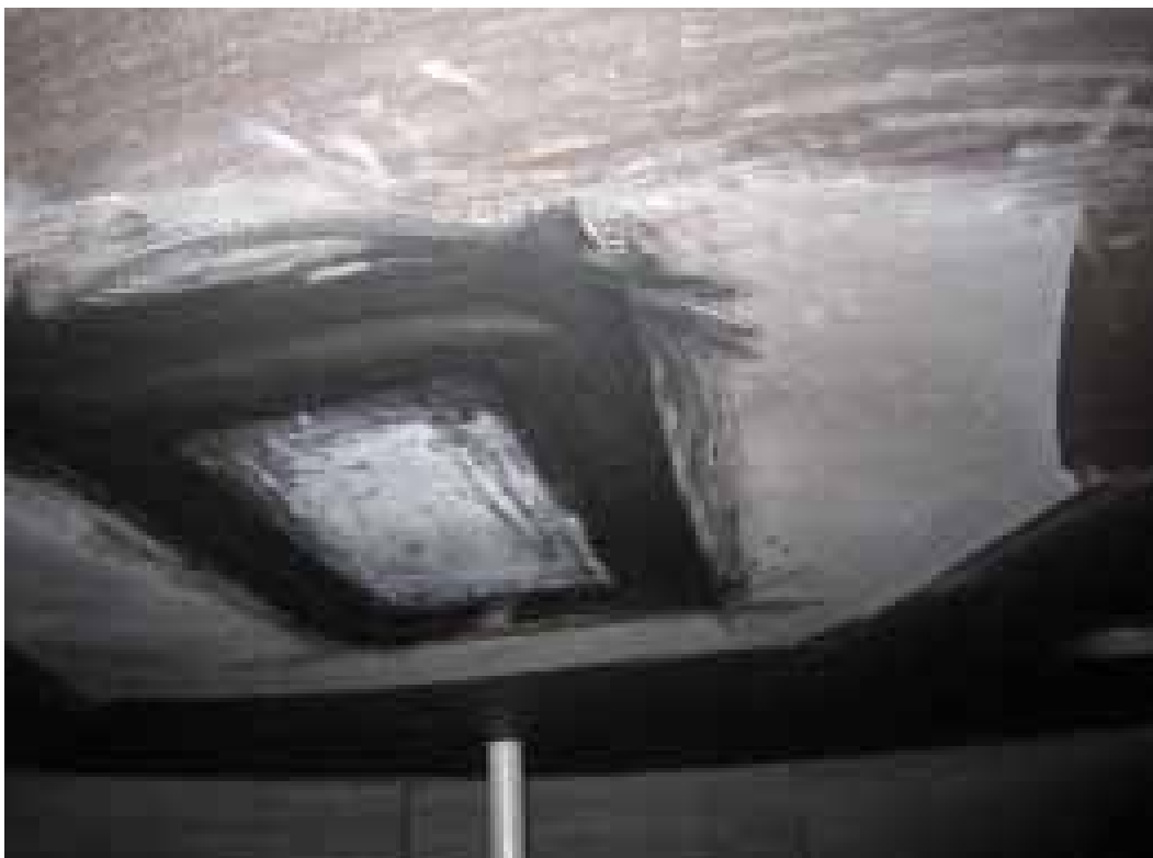
内面ゴムライニング補修状況
