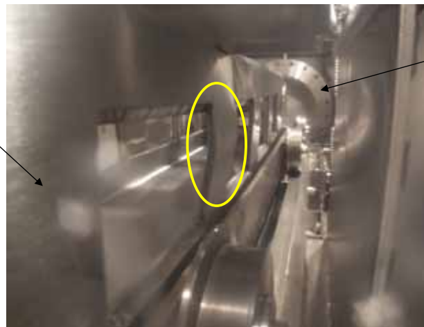
燃料コンテナの変形状況（反SFP側）
