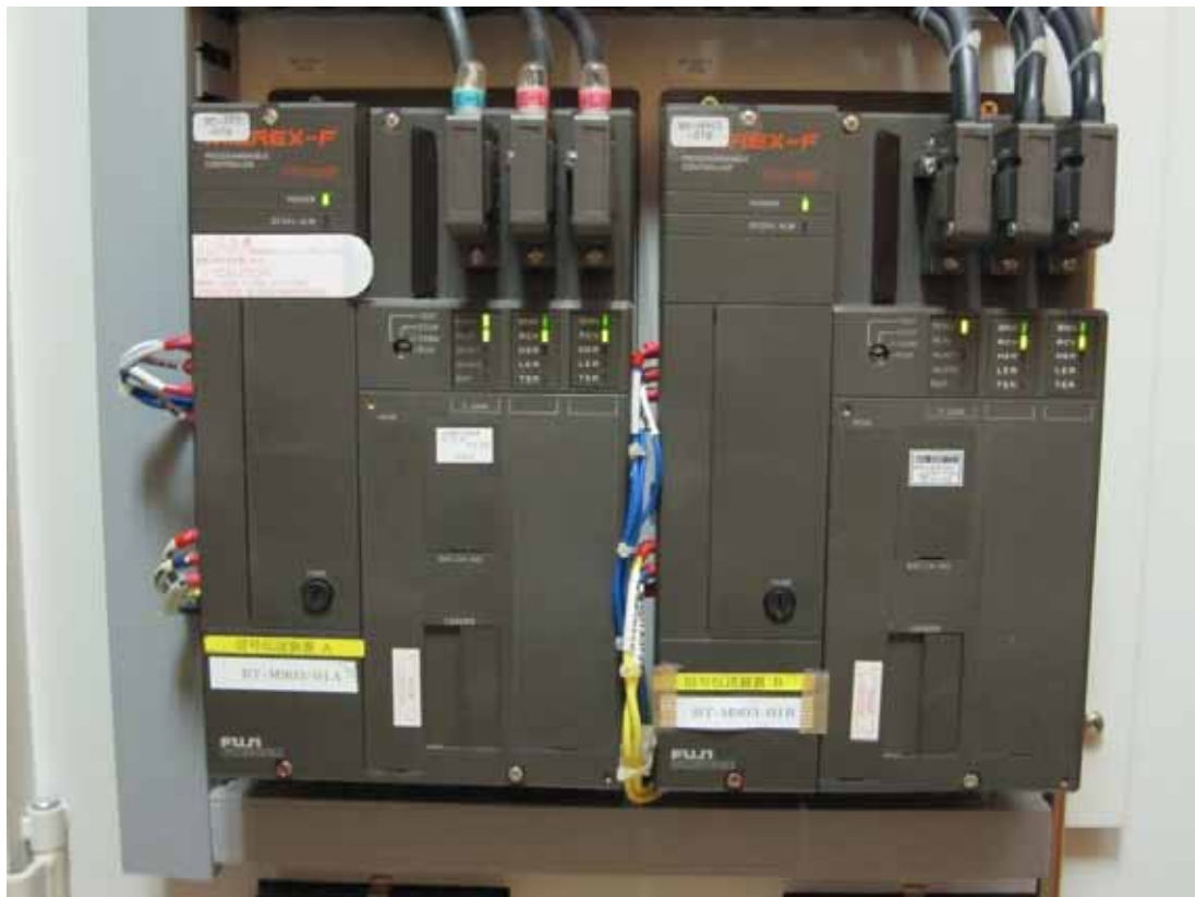
伝送装置（右側の伝送装置 B を取替）
