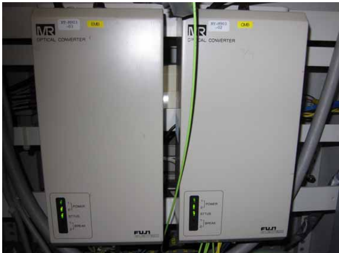
光コンバータ（左側の光コンバータ B を取り替え）
